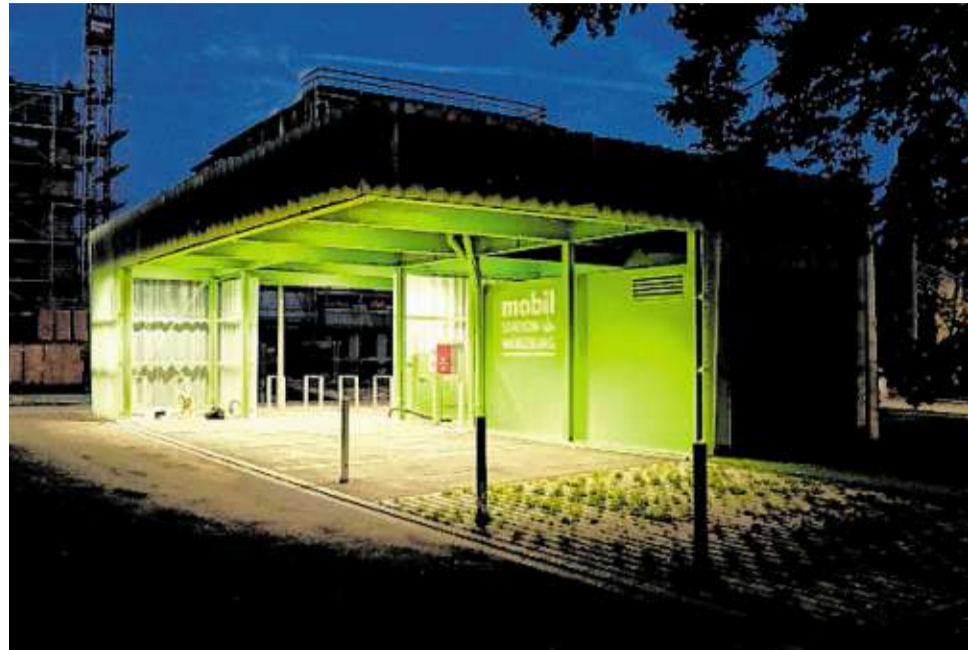
Nach Plänen der Architekten Deffner Voitländer entstand eine Mobilstation im neuen Stadtteil Hubland. FOTO: DOROTHEA VOITLÄNDER
